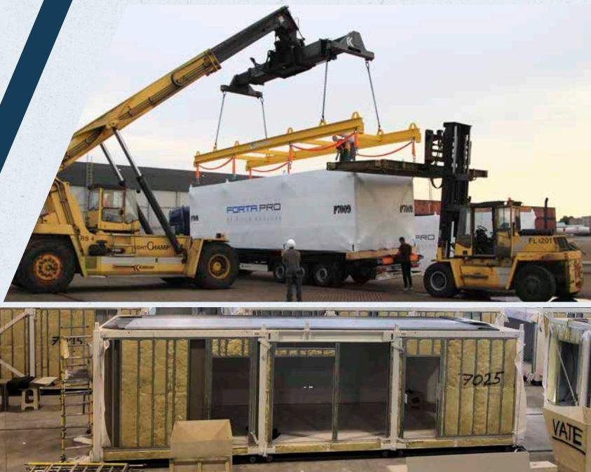
Kopš 2016. gada "Forta Prefab" MKC pārraudzībā izstrādā universālu modulāro metāla konstrukcijas projektu ar universālām pielietošanas iespējām. Projekta laikā "Forta Prefab" ir izstrādājis moduļu konstrukcijas sistēmu, kas ir piemērota ēkām ar visdažādāko funkciju, tostarp medicīniskās aprūpes būvēm, viesnīcām, dzīvojamajām ēkām, studentu vai veco ļaužu kopmītnēm utt.
